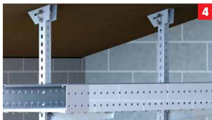
**Pričvršćivanje UD nosača na kosi betonski plafon pomoću anker vijaka tipa PEKOM FAZ II.**
