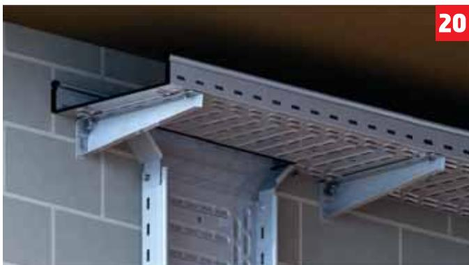
Montažom vertikalne ugradne račve postiže se efekat odlivnog levka po visini.
