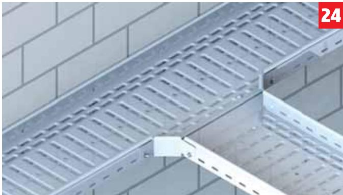
Bočno usecanje regala i montaža ugradne račve vrši se na licu mesta. Ugradna račva na usečeni deo regala pričvršćuje se torban vijcima tipa PEKOM M6 x 12 bez dodatnih spojnica.
